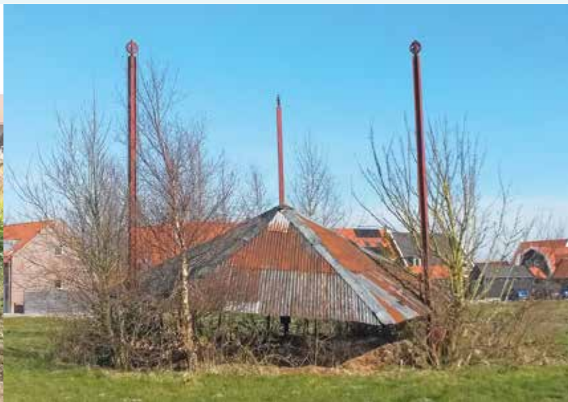
Juunren en hooiberg voor de restauratie
